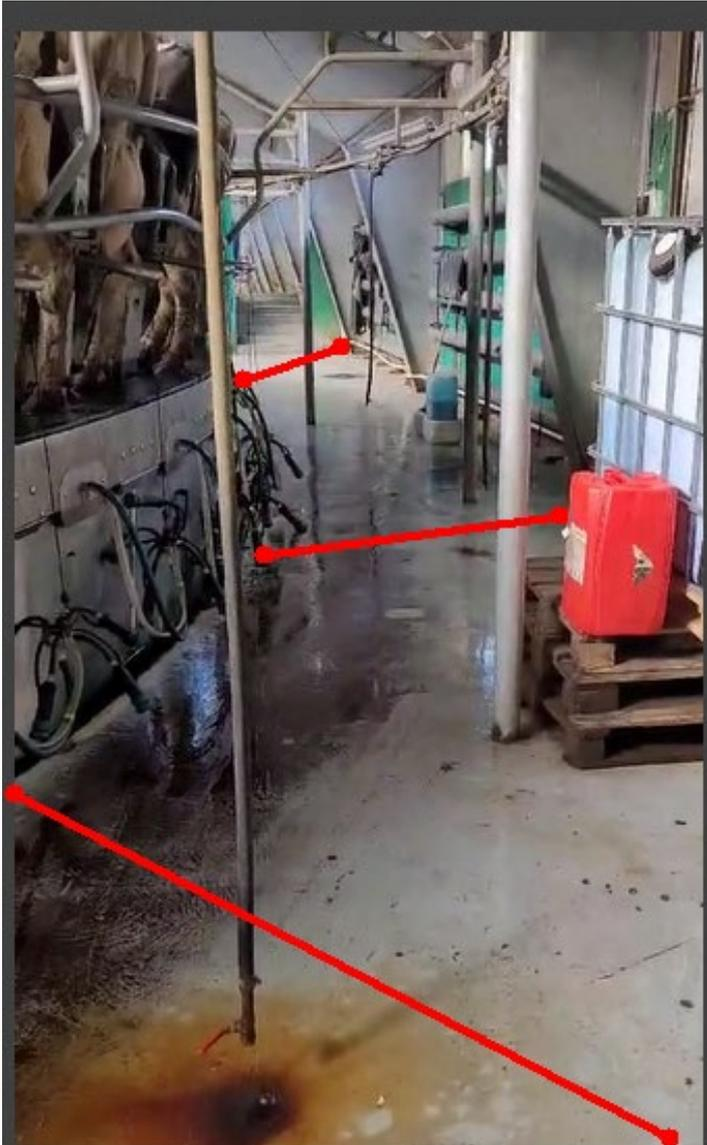
4. Удалить всю свободную воду с поверхности сектора при помощи резиновой ракеля, от внешнего контура к внутреннему. При помощи промышленного пылесоса и ветоши, осушить поверхность до матового вида (присутствие луж и поверхности с бликами недопустимо!).
