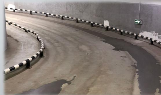
**Нанесение противоскользящего защитного покрытия на поверхности проходных зон для безопасного передвижения жильцов.**
